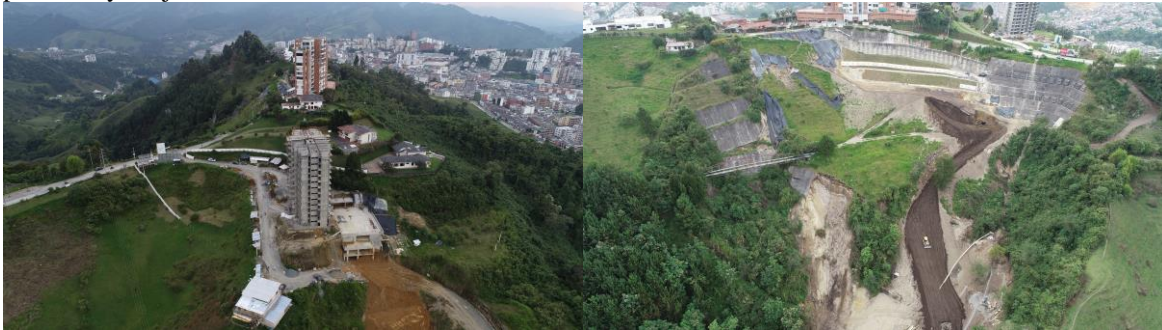
Figura 9. Obras de tratamiento geotécnico - muros de contención, pantallas ancladas activas, empradizado, perfilado y zanjas recolectoras, sector Cerro de Oro.
