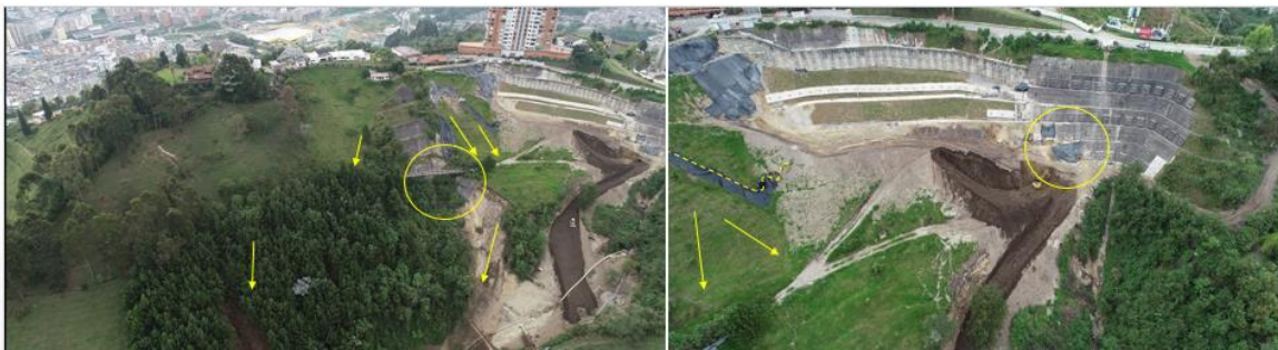
Figura 17. Zona Cerro de Oro, falencias de obras de intervención.
