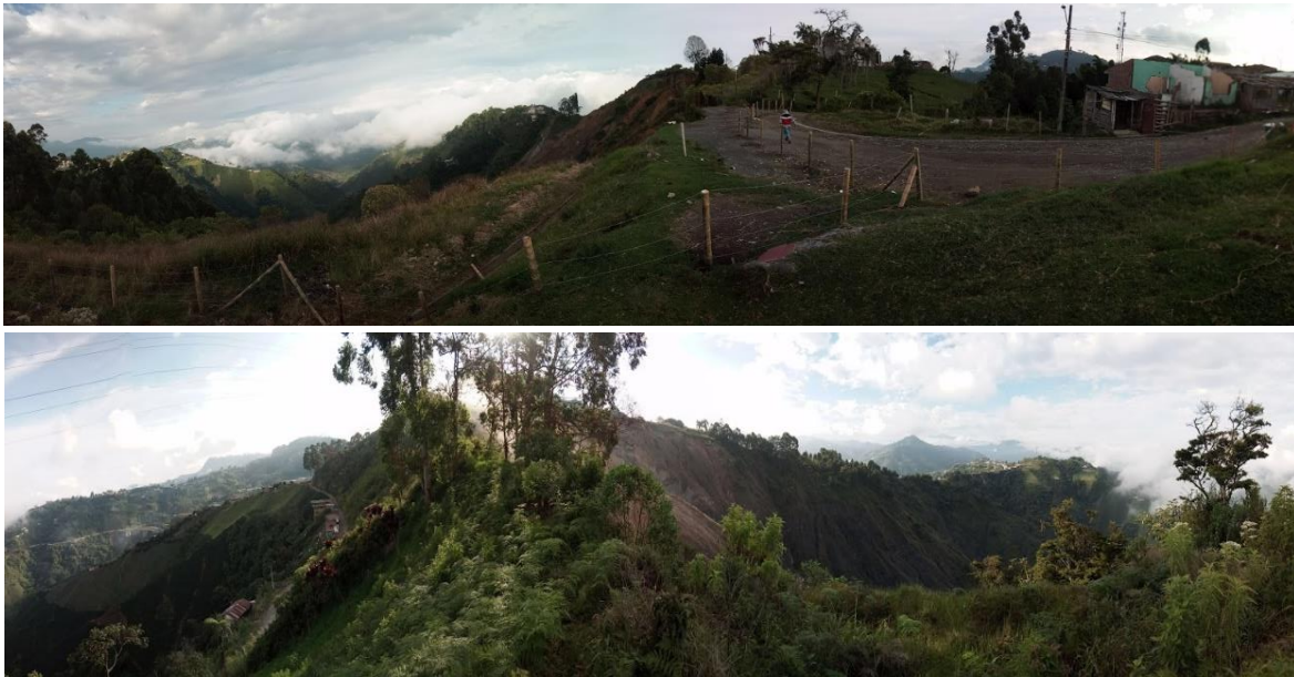
Figura 19. Zona alto Tablazo, falencias de obras de intervención.
