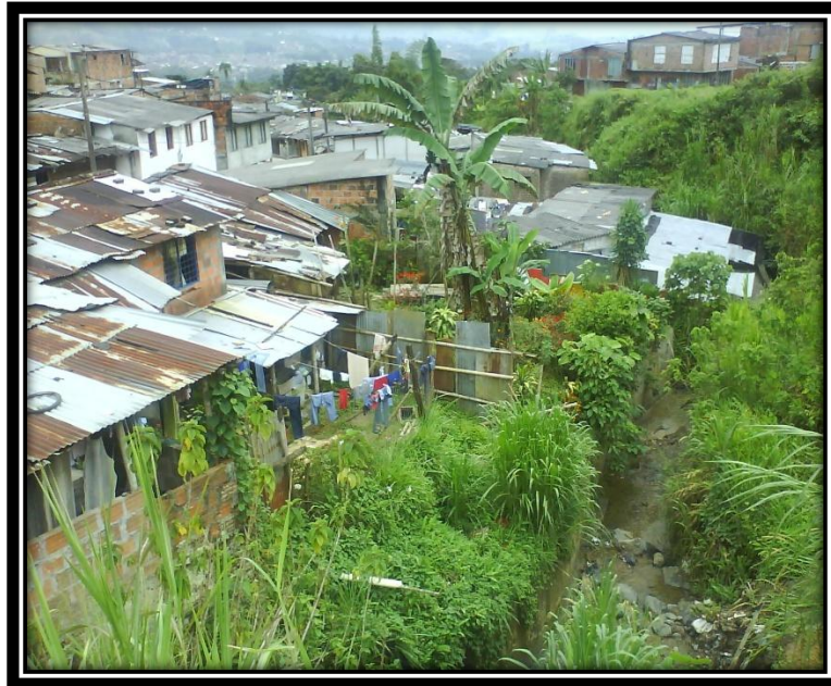
Figura 17 Quebrada Cordoncillo sector Barrio Los Pinos. Viviendas en la zona de protección de la quebrada.
