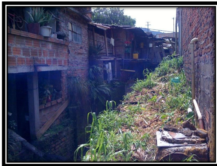
Figura 10 Disposición de residuos sólidos y escombros.
