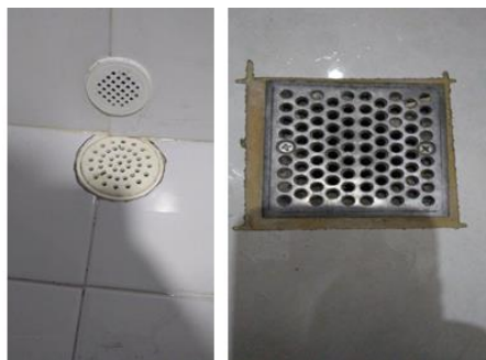
Ilustración 9. Desagües y rejillas instalados.
