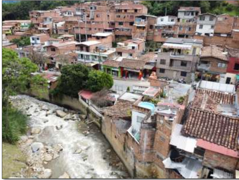
Figura 65. Viviendas ubicadas en la margen derecha aguas abajo en la Quebrada Santa Elena.
