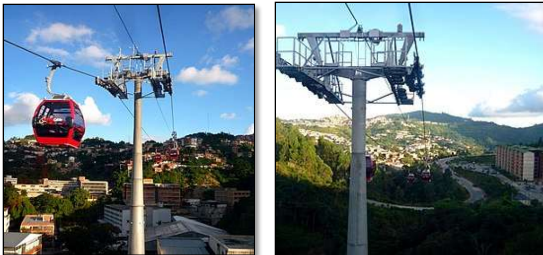
Figura 6. Metrocable de Mariche, segunda Línea del Metrocable de Caracas.
