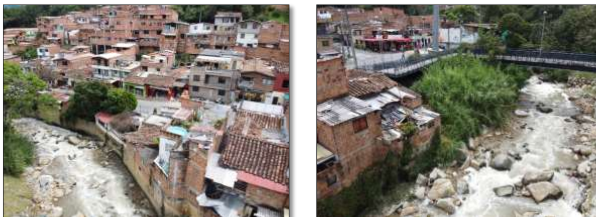
Figura 50. Viviendas expuestas en la franja de la quebrada Santa Elena.
