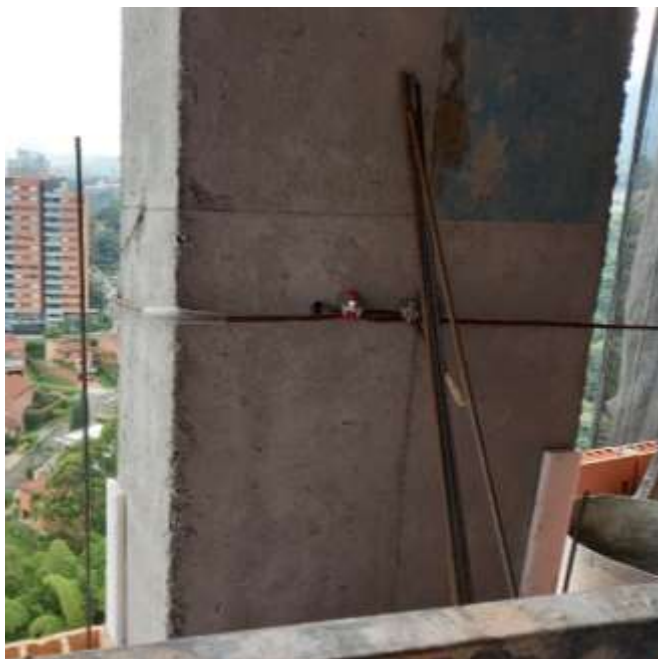
Fig. 6. Fotos en anclajes con perforado en estructura de concreto. Archivo del autor
