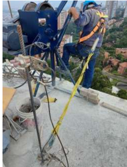
Fig. 13. Imagen de medida restrictiva fija. Autoría propia.
