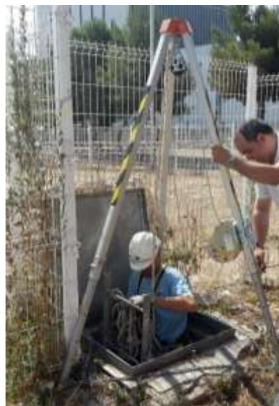
Fig. 9. Imagen de descenso en trípode de acceso a espacio confinado. (Trípode de Aluminio TRI 9 | Andamios colgantes y Plataforms Suspendidas, n.d.)
