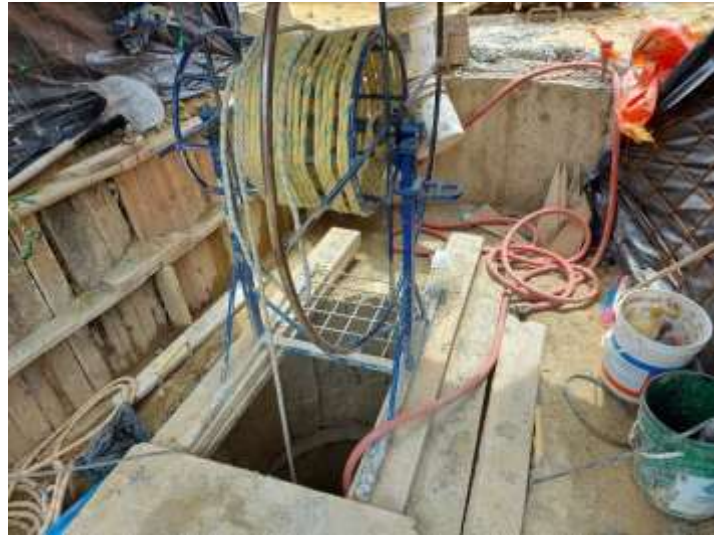
Fig. 11. Imagen de un molinete manual para retiro de tierra en espacio confinado. Autoría propia.
