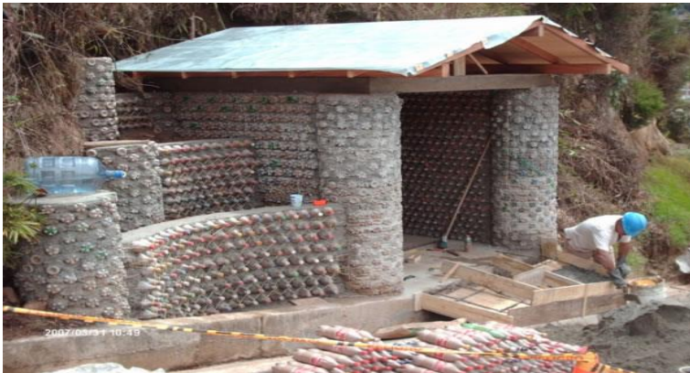
Imagen 5: de ecoladrillo de baja transformación con material base del PET
