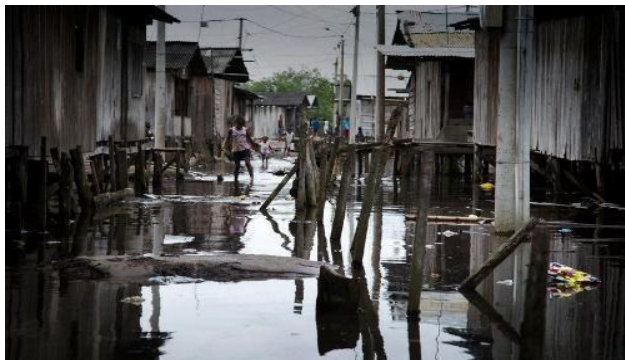
Imagen 14: Viviendas construidas de trozos de maderas https://verdadpacifico.org/tumaco-conflicto-armado-en-medio-de-la-paz/
