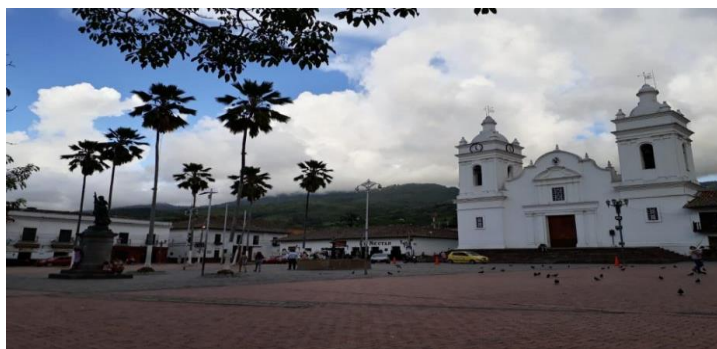
Figura 1: Catedral San Miguel Arcángel, Guaduas- Cundinamarca. Fuente propia.
