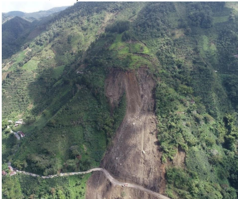
Figura 37. Fotografía aérea realizada en visita técnica al sitio crítico localizado en la vía Petaqueros-Manzanares, sector El Buenavista, municipio de Manzanares.
