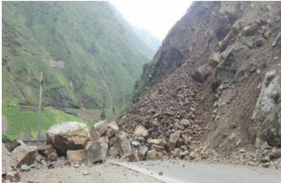
Figura 1. Fotografía caídas o desprendimientos de rocas.
