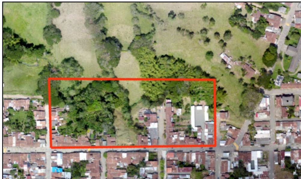
Figura 17. Ubicación de zona y viviendas visitadas en el norte de la cabecera municipal de Viterbo, Caldas.
