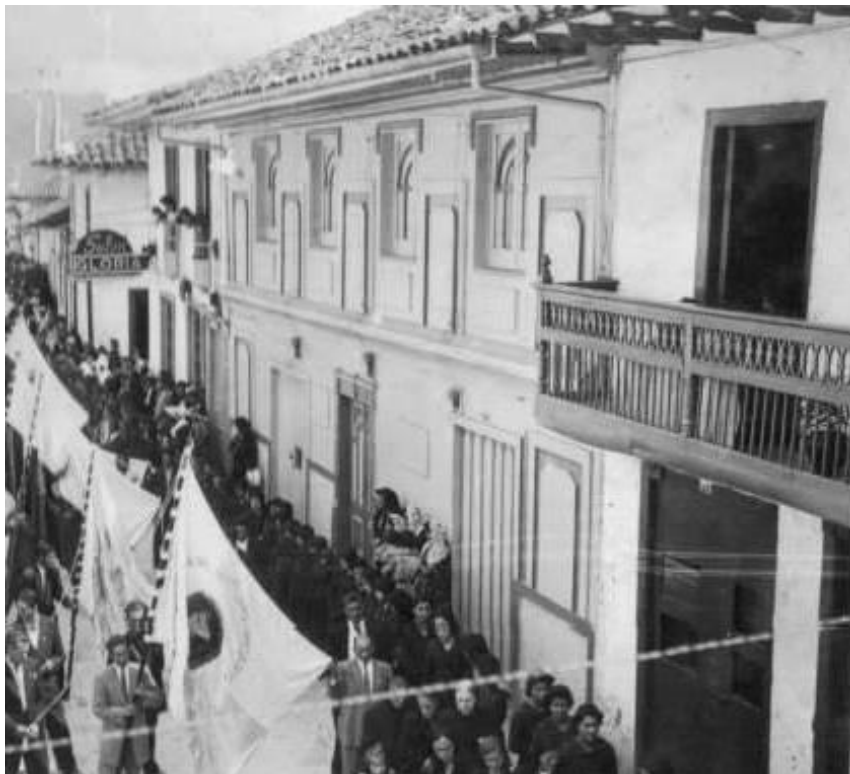
Imagen 14: fachada antigua casa de los abuelos. Fuente: portal Aranzazu al día.
