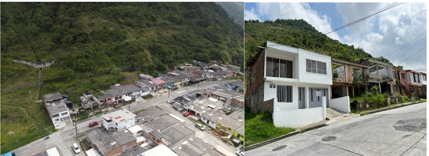
Figura 7. Zona Afectación, Carrera 40 y Calle 72
