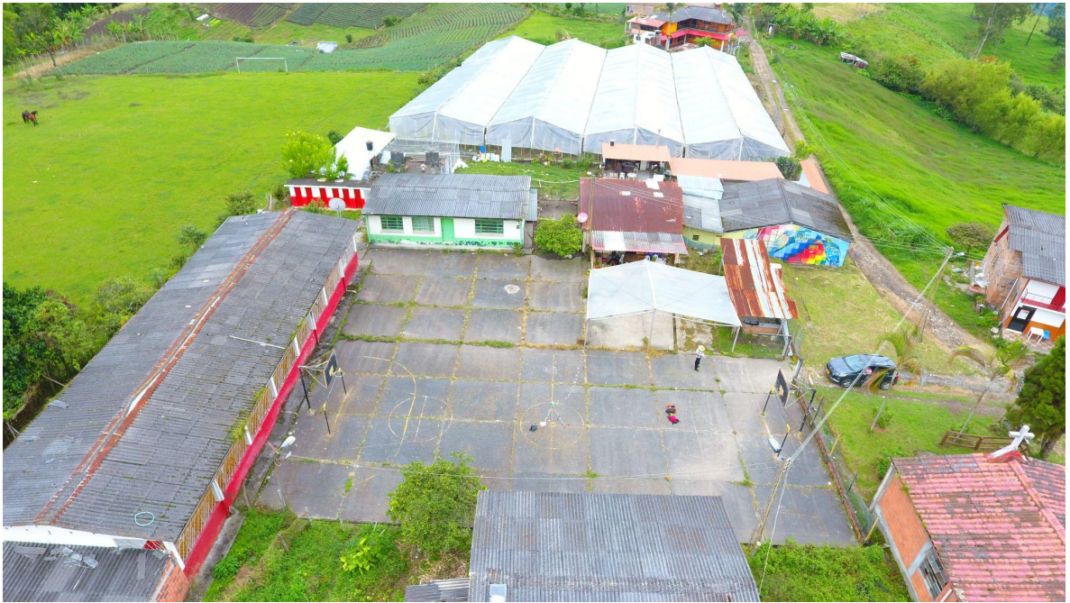
Imagen 8 , Vereda Santo Domingo, Villamaría, Caldas, Colombia, Urbanismo actual. Los Autores, 2021.
