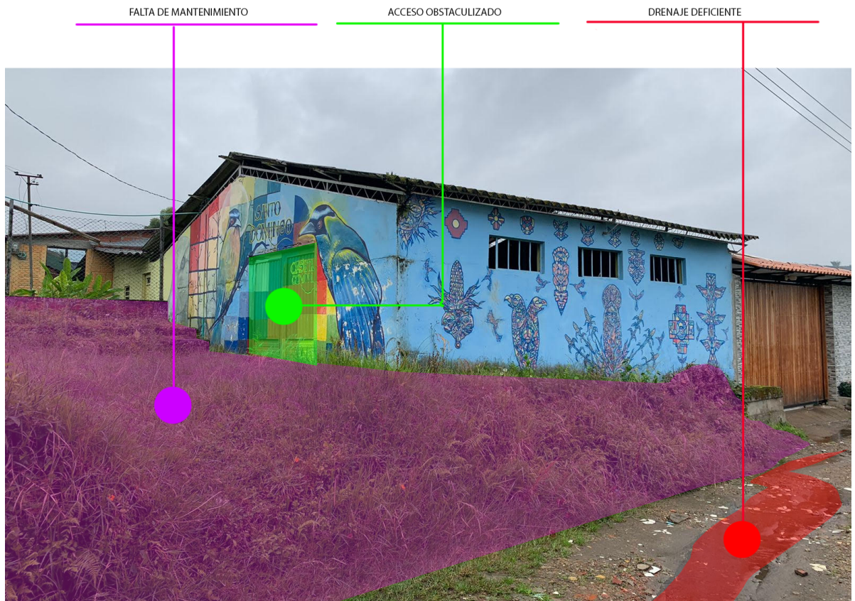
Imagen 5 , Identificación de diferencia de niveles en la vereda Santo Domingo, Villamaría, Caldas, Colombia. Los Autores, 2021.
